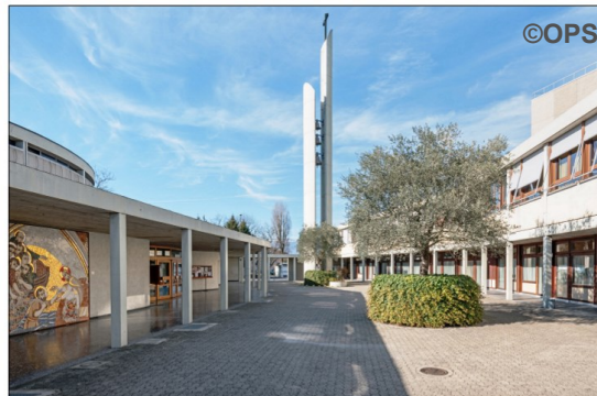
Eglise Saint-Martin-Onex (Construction : 1963)
